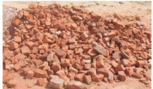
टूटी ईंटों को पास रखें ताकि साबुत ईंटों को तोड़ना ना पड़े।
