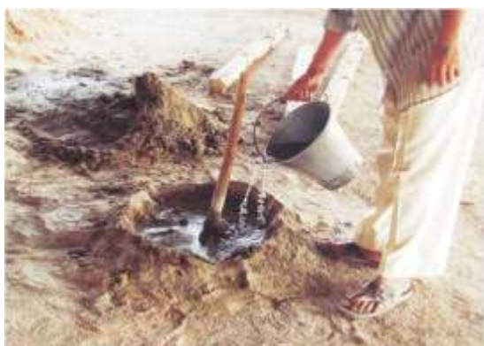
निर्माणाधीन भवन के पास साफ, समतल एवं पक्का जगह पर मसाला बनाएं।
