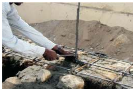
खड़े छड़ों को बैंड के छड़ों के साथ बांधने के लिए 'L' आकार के छड़ों का उपयोग करें।
