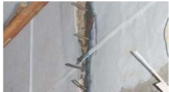
'V' खाँचे में 150 – 200 मि.मी. की दूरी पर, दरार में 6 मि.मी. प्लास्टिक का ग्राउट पाईप का टुकड़ा फँसाएं। दरार को 1:3 के सीमेन्ट मसाले से बंद कर दें।
